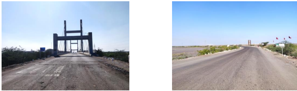
Project End Point (Kalatalav in Bhavnagar)
